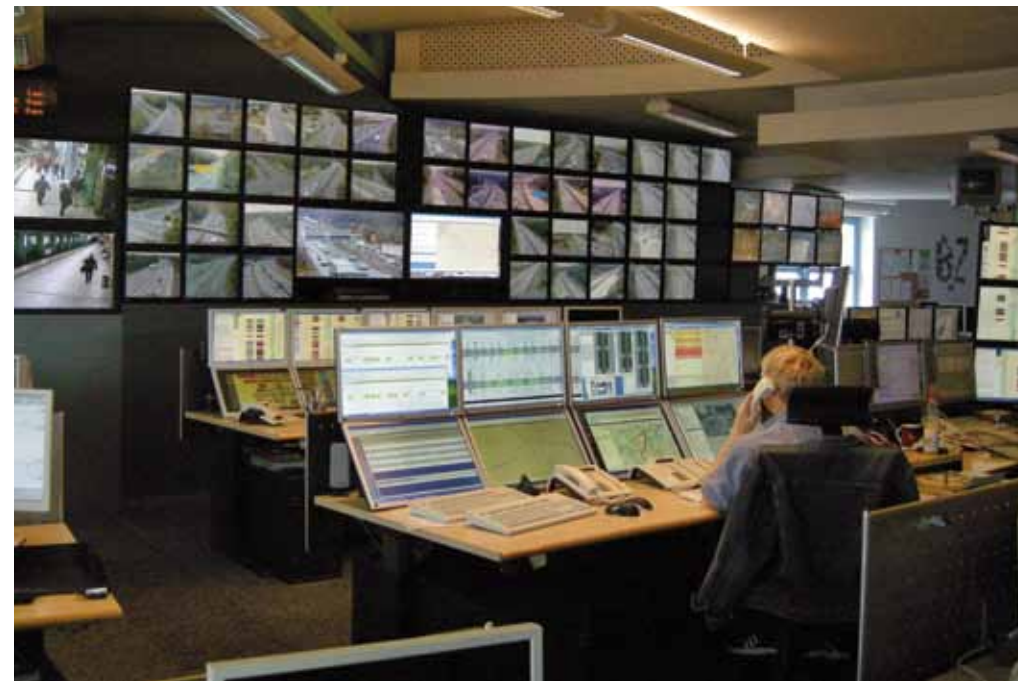
Serce sieci komunikacyjnej Hanoweru. Wspólna centrala zarządzająca ruchem samochodów na drogach, komunikacją miejską i podmiejską. W jej pomieszczeniach mają stanowiska wszyscy przewoźnicy obsługujący region
