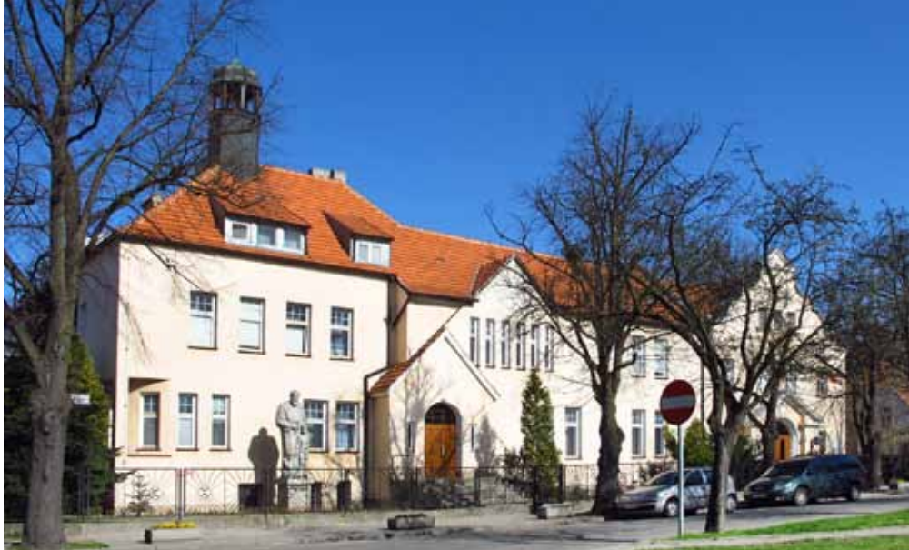
Dom Generalny wielkopolskiej gałęzi Zgromadzenia Sióstr Służebniczek Niepokalanego Poczęcia NMP w Luboniu-Żabikowie, fot. Z. Szmidt
