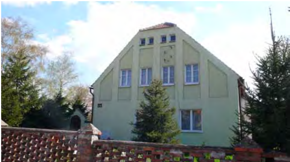
Dom mieszkalny, ul. Dworcowa 53, fot. Z archiwum Stowarzyszenia Golęczewian
