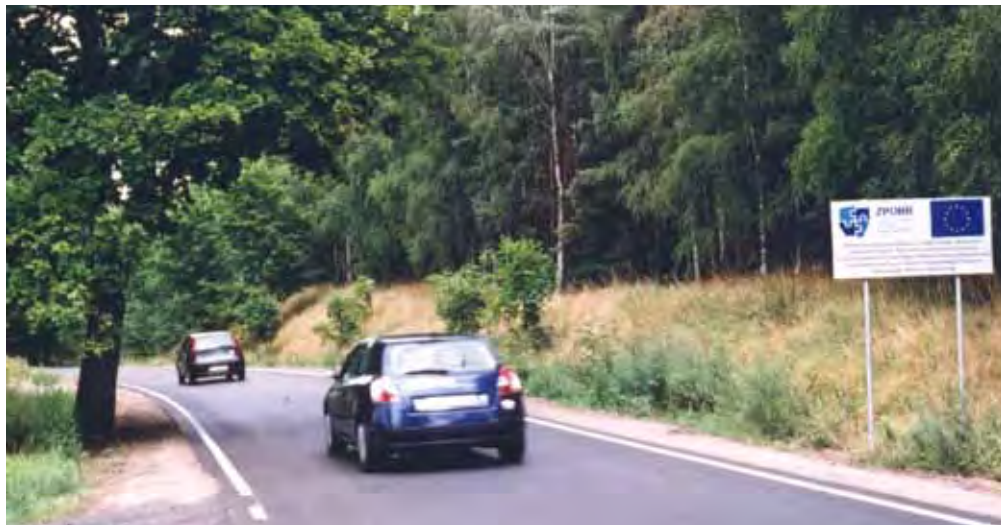
Droga powiatowa nr 2406P z Poznania (Radojewa) do Biedruska po zakończeniu modernizacji wykonanej przy wsparciu funduszy unijnych (2005 r.), fol. P. Anders
