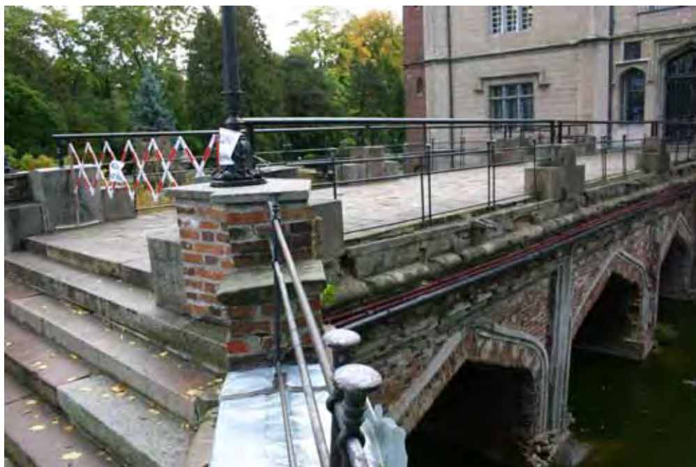
Most przed remontem, fot. Z. Nowakowski
