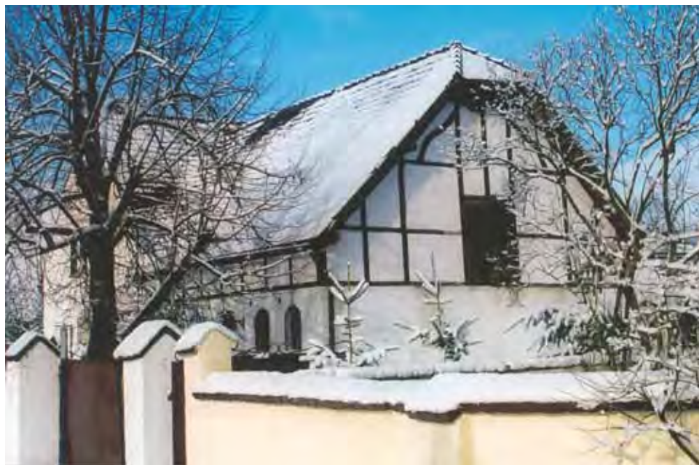
Część gospodarcza przylegająca do budynku mieszkalnego, ul. Dworcowa 44, fot. Z archiwum Stowarzyszenia Gołęczewian
