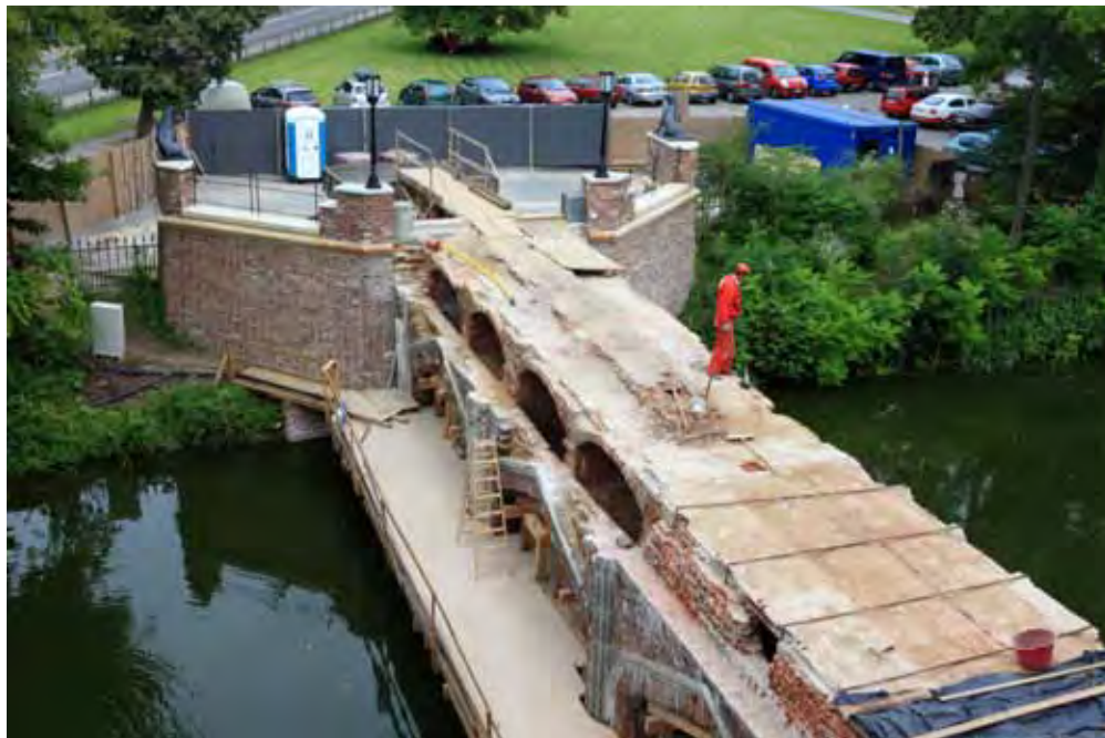
Most w trakcie remontu, fot. Z. Nowakowski
