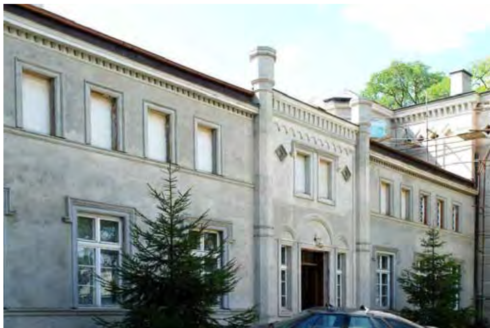
Pałac w Lusowie, elewacja zewnętrzna, fot. Z. Szmidt
