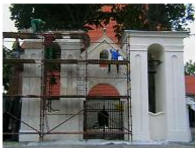
Remont bramy - dzwonnicy przy kościele p. w. Św. Wawrzyńca w Niepruszewie
