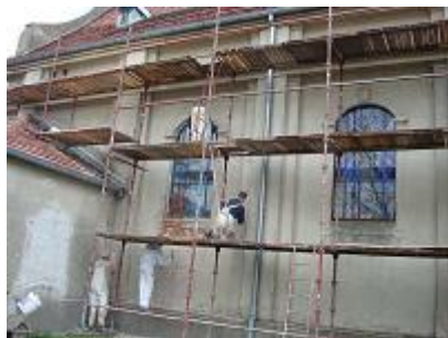
Prace remontowo - konserwatorskie elewacji kościoła parafialnego p. w. św. Idziego w Modrzu
