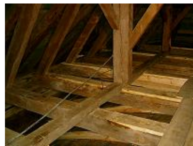
Impregnacja więźby ciesielskiej dachu kościoła p. w. Św. Kazimierza w Gultowach
