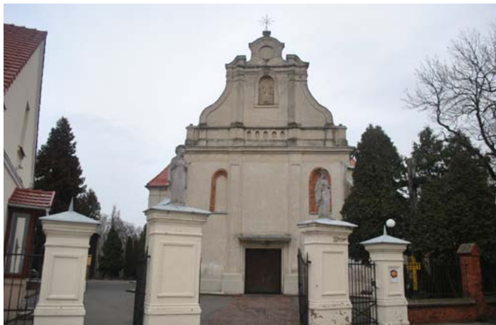
Kościół pw. św. Trójcy w Stęszewie. Fot. A. Ogórkiewicz
