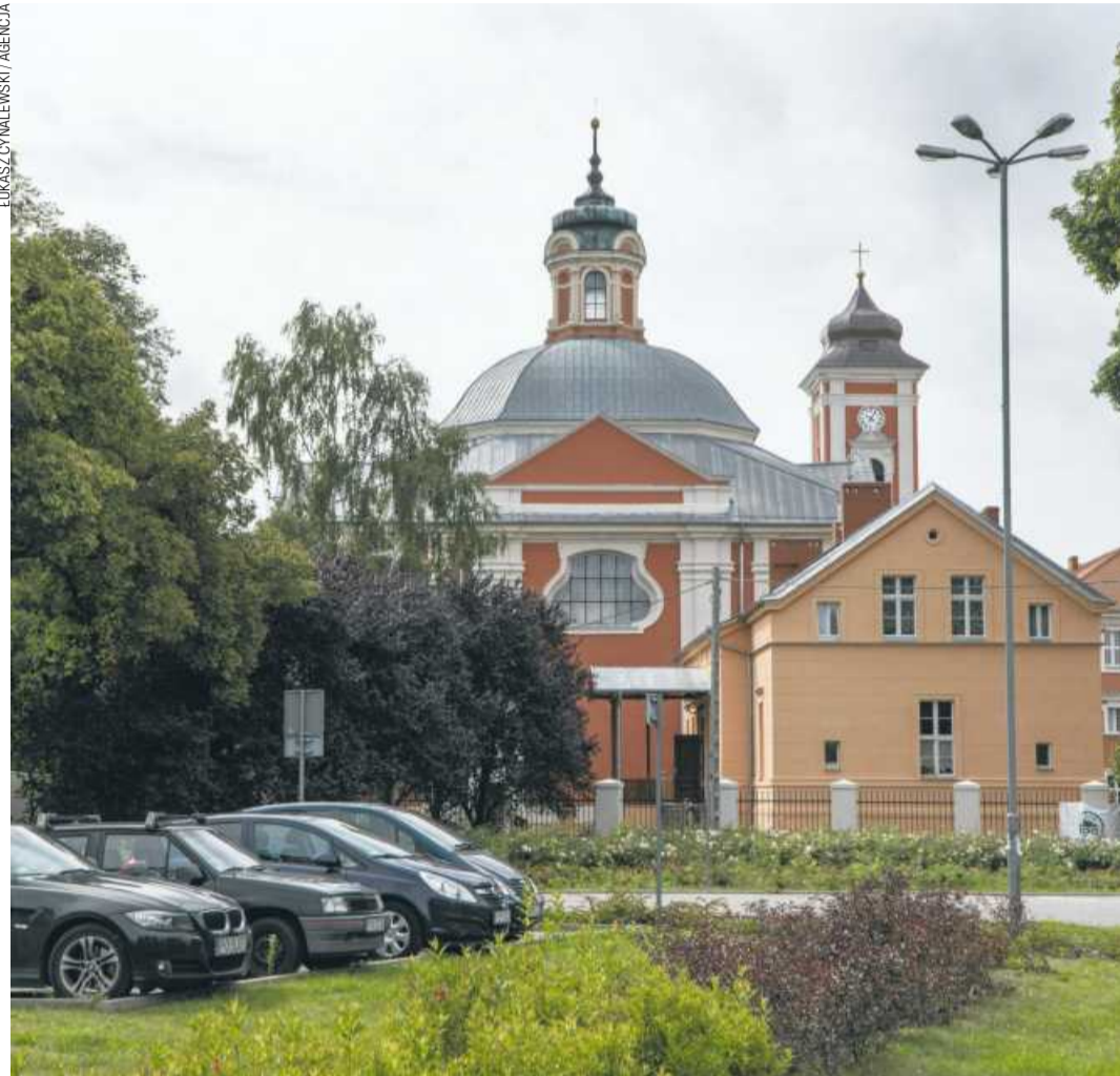
Zespół pocysterski w Owińskach od kilku lat przechodzi gruntowną modernizację
