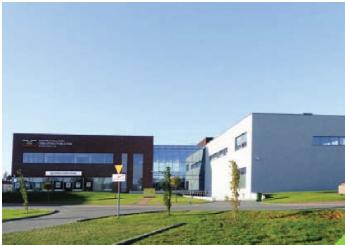
Centrum Kultury i Biblioteka Publiczna Gminy Suchy Las. Fot. A. Ogórkiewicz
