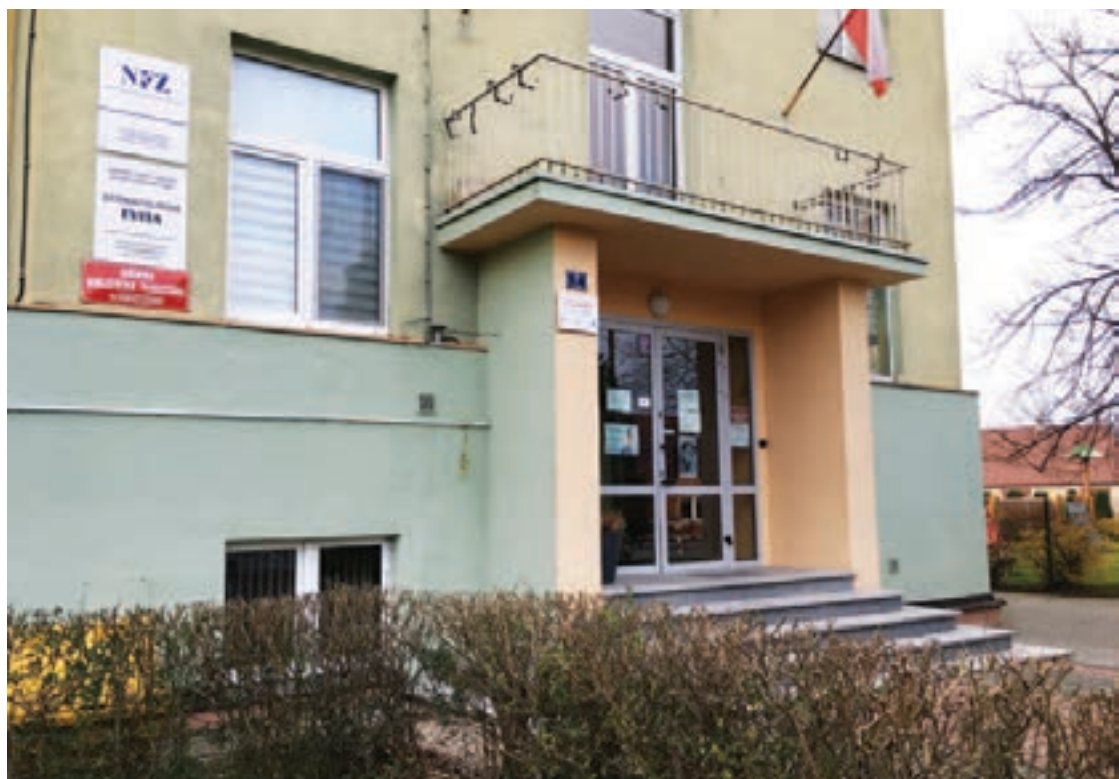
Biblioteka w Kleszczewie. Fot. A. Sołtysiak
