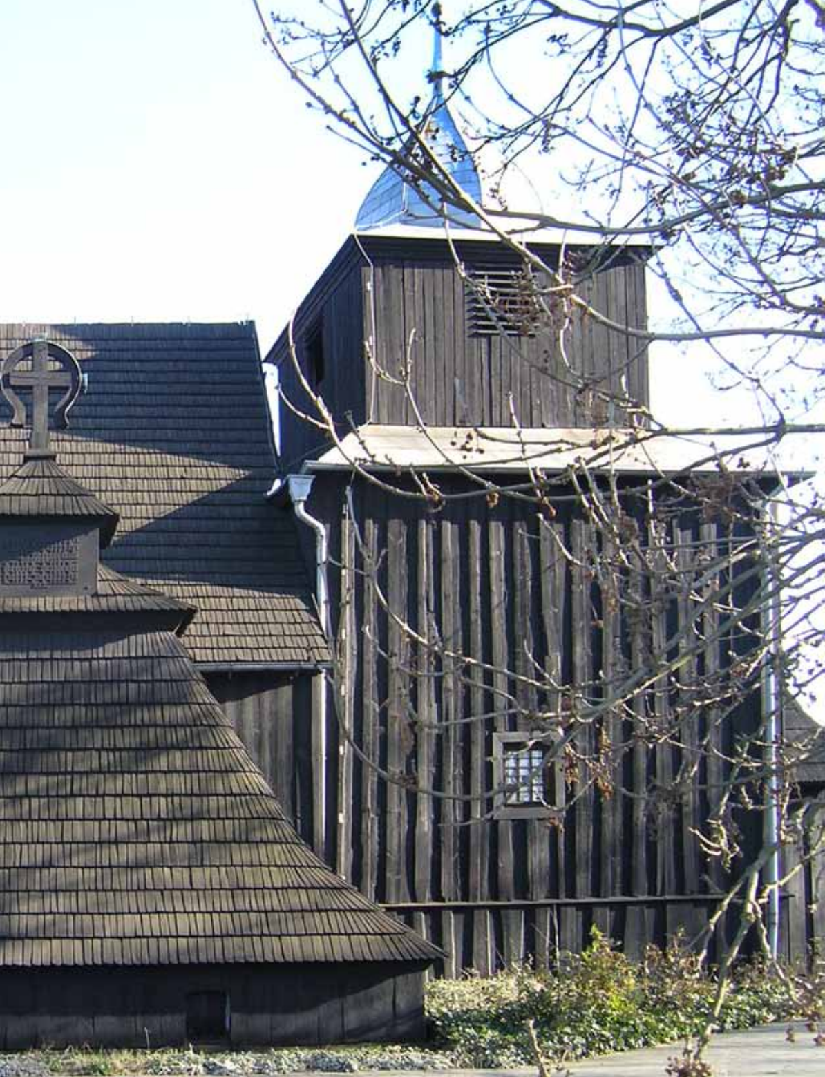
Kościół pw. św. Mikołaja w Wierzenicy z zewnątrz, fot. Z. Szmidt
