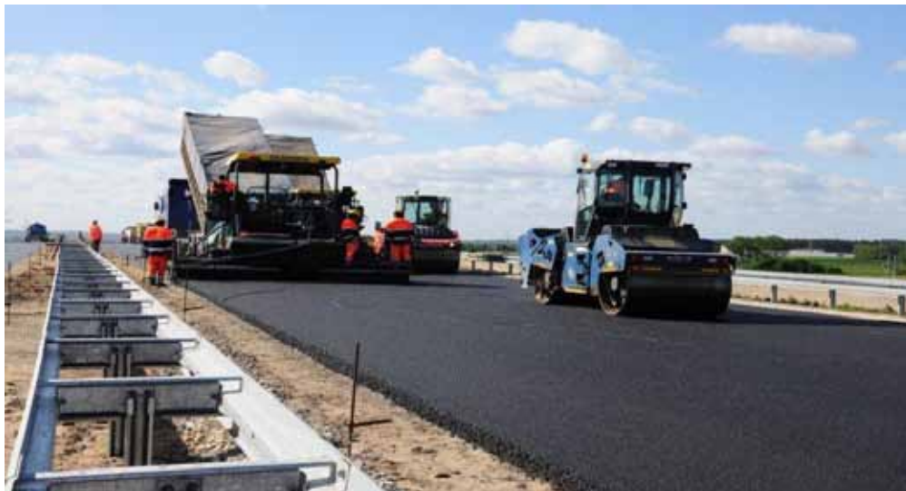
S11 Zachodnia Obwodnica Poznania, układanie masy bitumicznej, fot. z archiwum GDDKiA Oddział w Poznaniu
