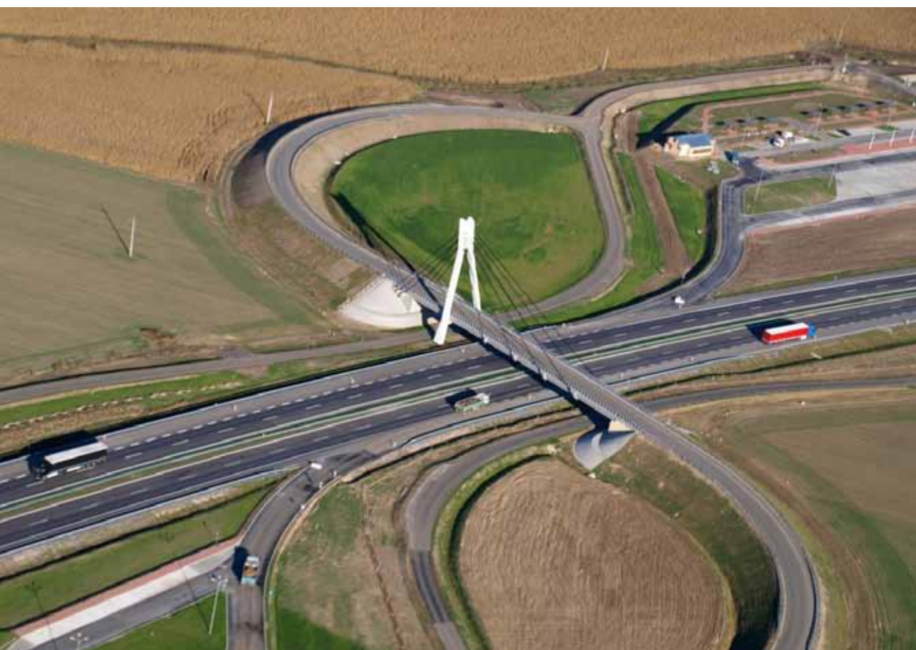
Droga S5 Gniezno–Poznań, wiadukt podwieszany – kładka dla pieszych przy MOP Czerlejnko, foto z archiwum GDDKiA Oddział w Poznaniu
