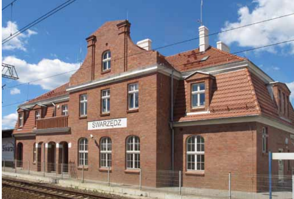
Wyremontowany dworzec PKP w Swarzędzu, fot. Z.Szmidt
