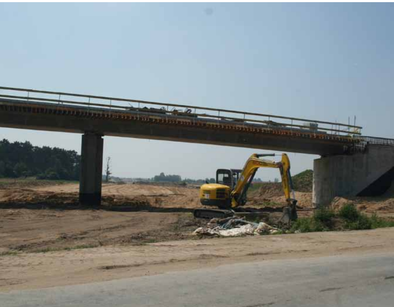
Budowa drogi ekspresowej S 5 w okolicach Trzeka (maj 2011 r.), fot. P. Anders
