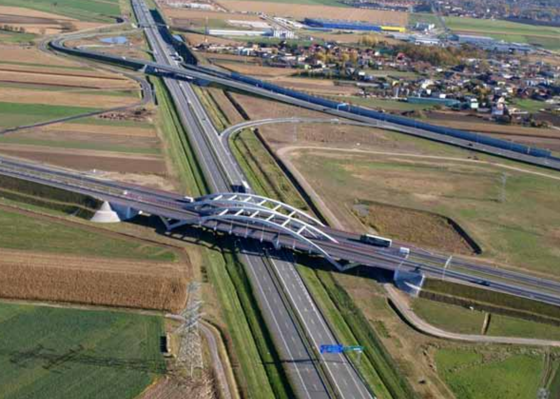
Wiadukt nad A2 węzeł Poznań Zachód w Głuchowie, początek drogi S5 Poznań–Wrocław, fot. z archiwum GDDKiA Oddział w Poznaniu (z lewej wylot na Swadzim, Piłę, góra do Komornik, Warszawy)
