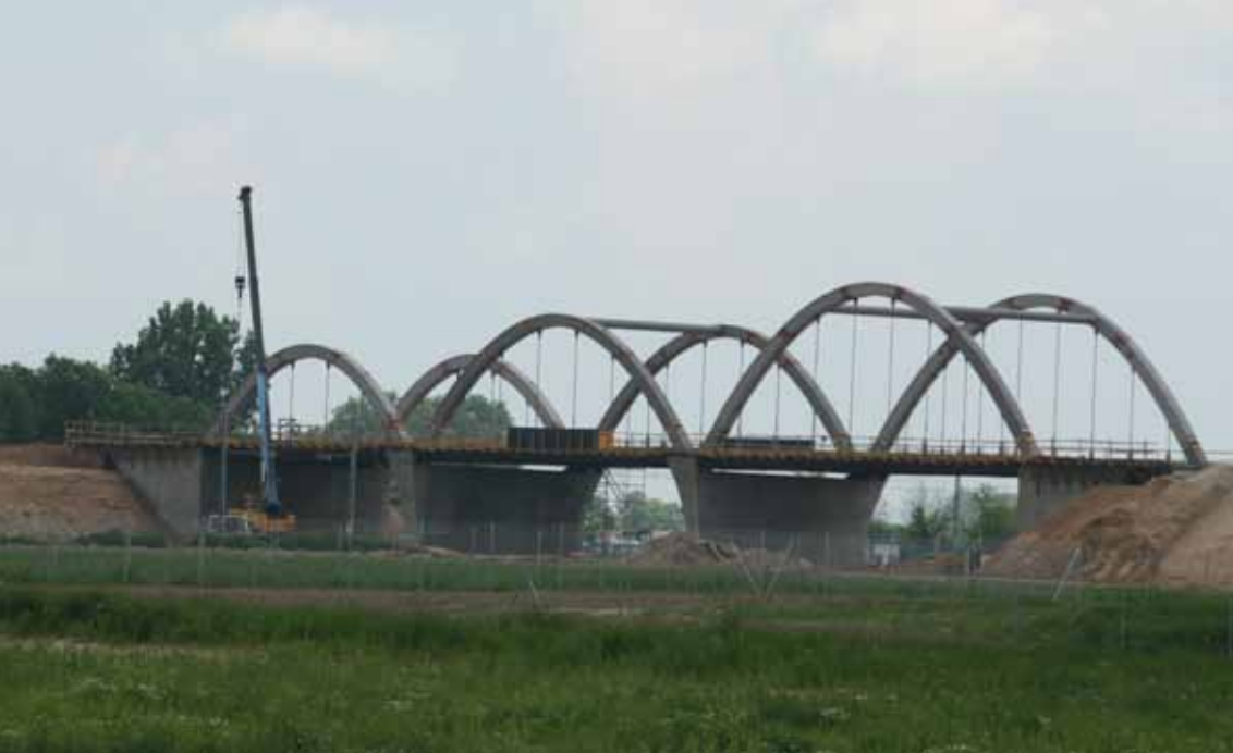
Wiadukt nad linią kolejową do Warszawy po wschodniej stronie Swarzędza – element budowanego przez Zarząd Powiatu łącznika do drogi nr 92, fol. P. Anders – czerwiec 2013 r.
