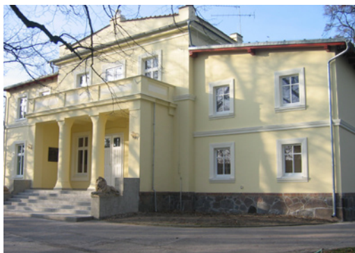
Centralny budynek Zespołu Szkół w Rokietnicy po termomodernizacji,
