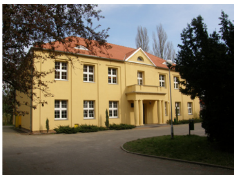
Budynek Domu Dziecka w Kórniku-Bninie po termomodernizacji, fol. Starostwo Powiatowe w Poznaniu
