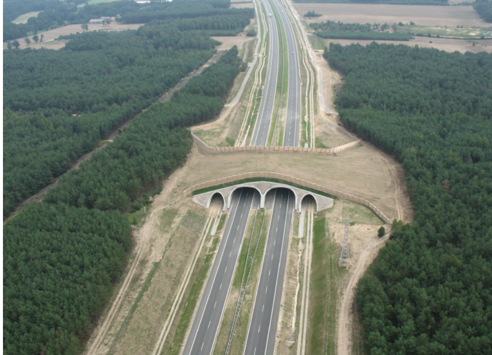
Przejście dla zwierząt nad Autostradą A2 między Koninem a Kolem. Dwa obiekty w tej technologii zostaną wybudowane na wschodniej obwodnicy Poznania, foto: GDDKiA
