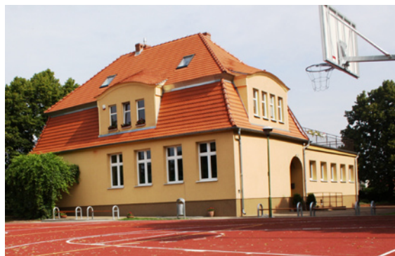
Budynek Zespołu Szkół w Rokietnicy – filia w Poznaniu po termomodernizacji,
