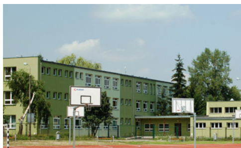
Budynek Zespołu Szkół w Mosinie po termomodernizacji, fol. Starostwo Powiatowe w Poznaniu
