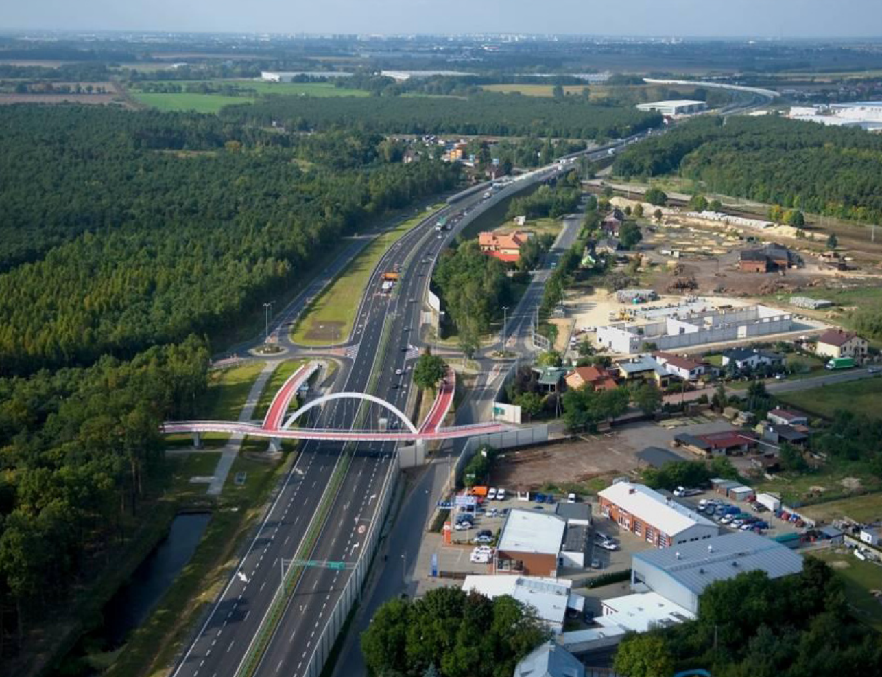
Gądky, droga nr 11 po modernizacji w 2009 r. fol. Z archiwum firmy Skanska Sp. z o.o.
