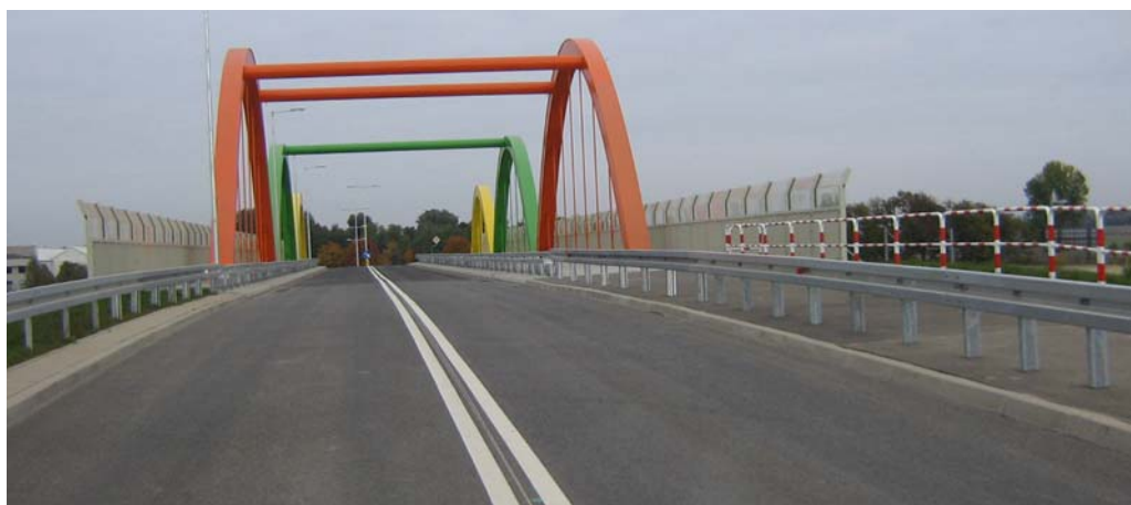
Wiadukt nad linią kolejową E-20 – I etap inwestycji.
