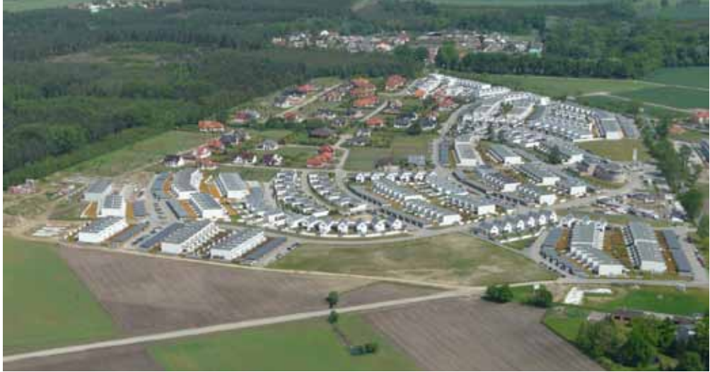
Dąbrówka (gm. Dopiewo) osiedle Osada Leśne – udana realizacja kompleksowego osiedla deweloperskiego, fot. M. Mikula
