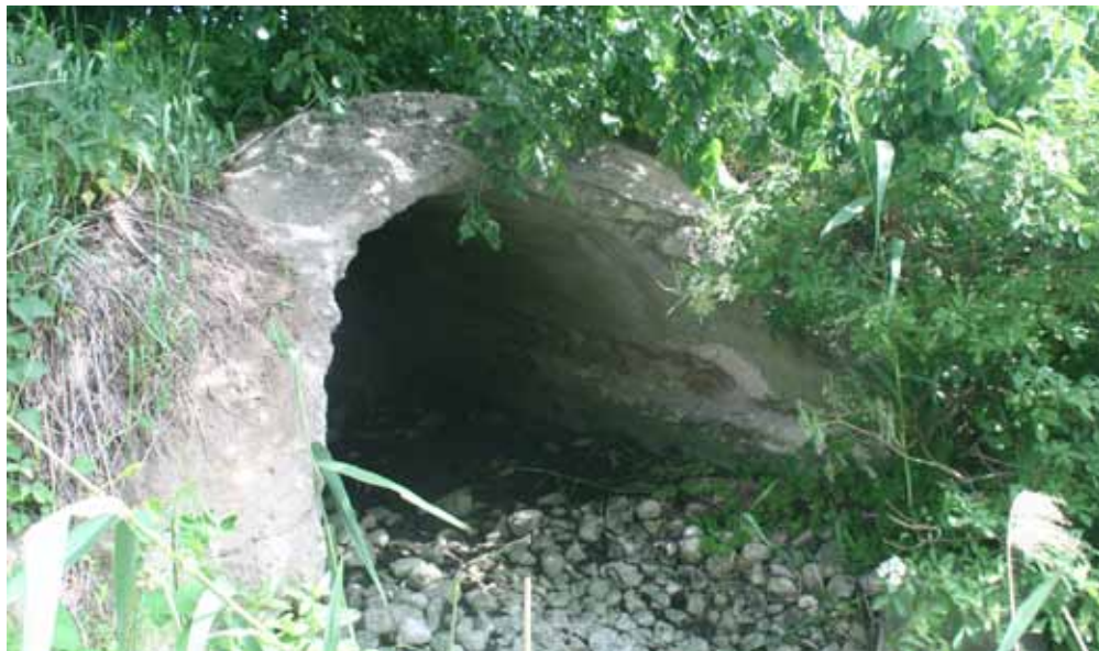
Przepust między Komornikami a Nagradowicami, fot. P. Anders
