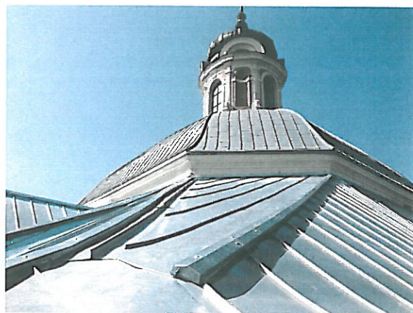
Po remoncie pokrycia dachowego
