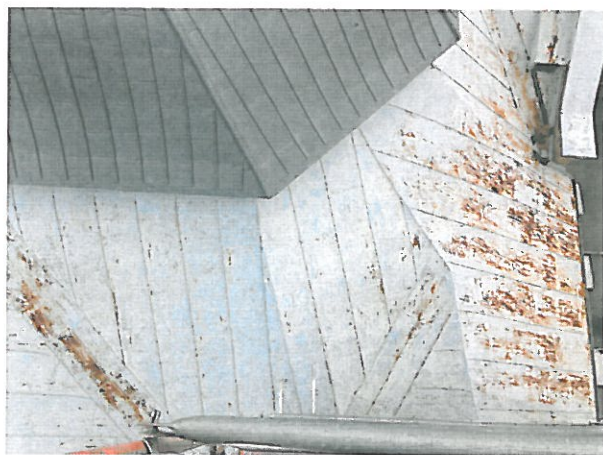
Przed remontem pokrycia dachowego
