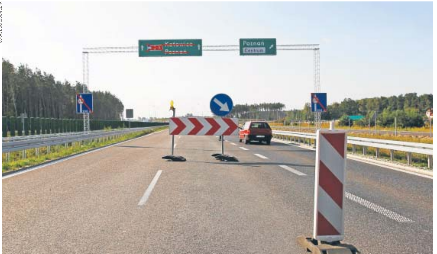
Władze powiatu chcą, by powstała północna obwodnica Poznania. Miałaby się ona zaczynać w Złotkowie, gdzie na razie kończy się ekspresowa droga S11
