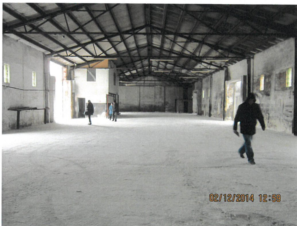
Budynek magazynu po usunięciu odpadów
