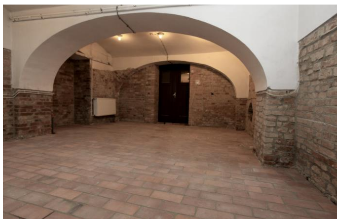
Przyziemia zamku w Kórniku – stan po wykonaniu prac polegających na osuszaniu.
