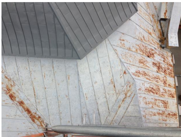
Przed remontem pokrycia dachowego
