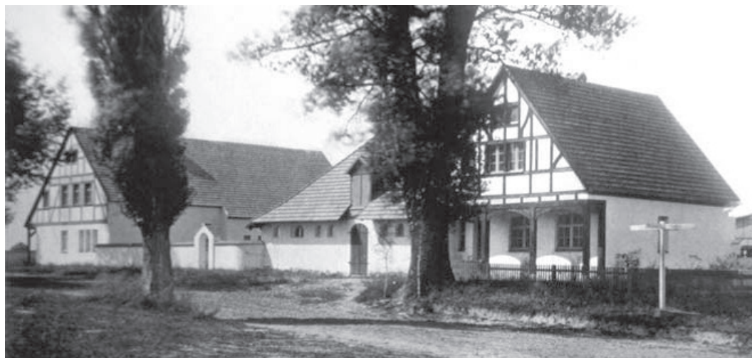
Budynek podcieniowy przy ul. Lipowej w Gołęczewie.
