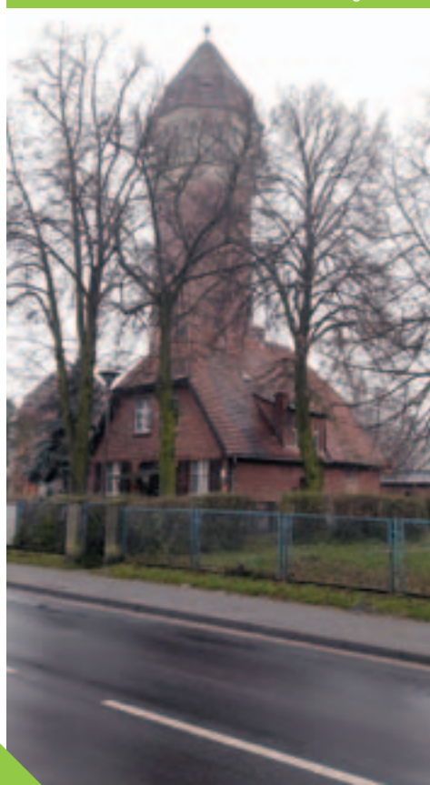
Wieża ciśnień w Buku. Fot. A. Ogórkiewicz
