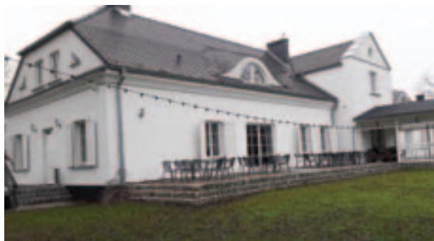
Dwór Augusta Cieszkowskiego w Wierzenicy. Fot. A. Ogórkiewicz
