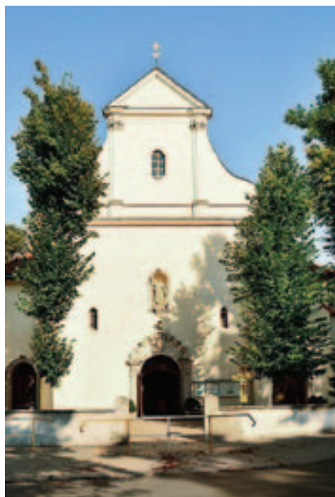
Kościół Parafialny pw. Św. Andrzeja Apostoła w Komornikach. Fot. T. Stachowiak
