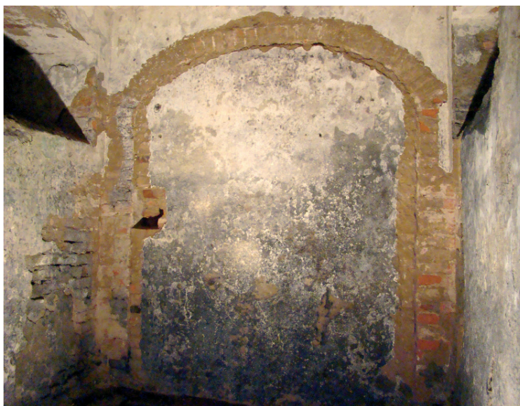
Fragment muru w wątku gotyckim (po lewej stronie) odkryty spod tynków. Prawdopodobnie relikw starzej, może średniowiecznej budowli. Fot. J. Borwiński.
