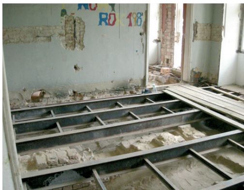
Wnętrze pałacu przed rozpoczęciem prac w 2007 roku. Fot. E. Leszczyńska.
