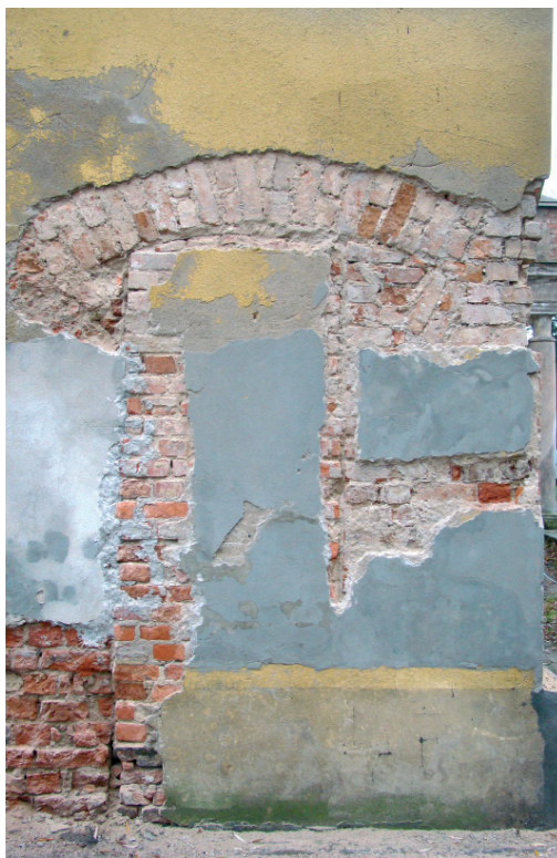
Odkryte w czasie badań przejście z korpusu budynku do dawnego, obecnie nieistniejącego, alkierza w narożu południowo-wschodnim. Fot. J. Borwiński.
