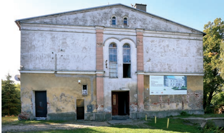
Elewacja północna pałacu.
