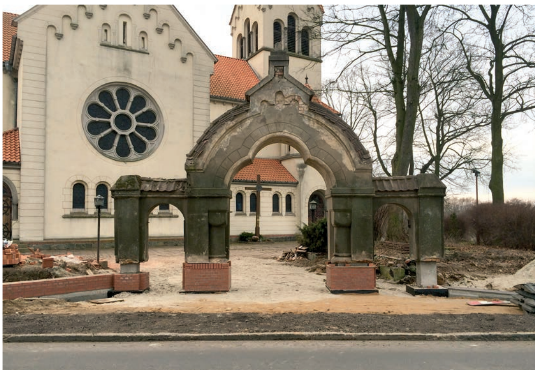
Widok bramy przeniesionej na nowe fundamenty. Fot. M. Lewicki
