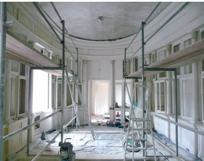
Remont skrzydeł pałacowych, 2012–14. Fot. E. Leszczyńska.
