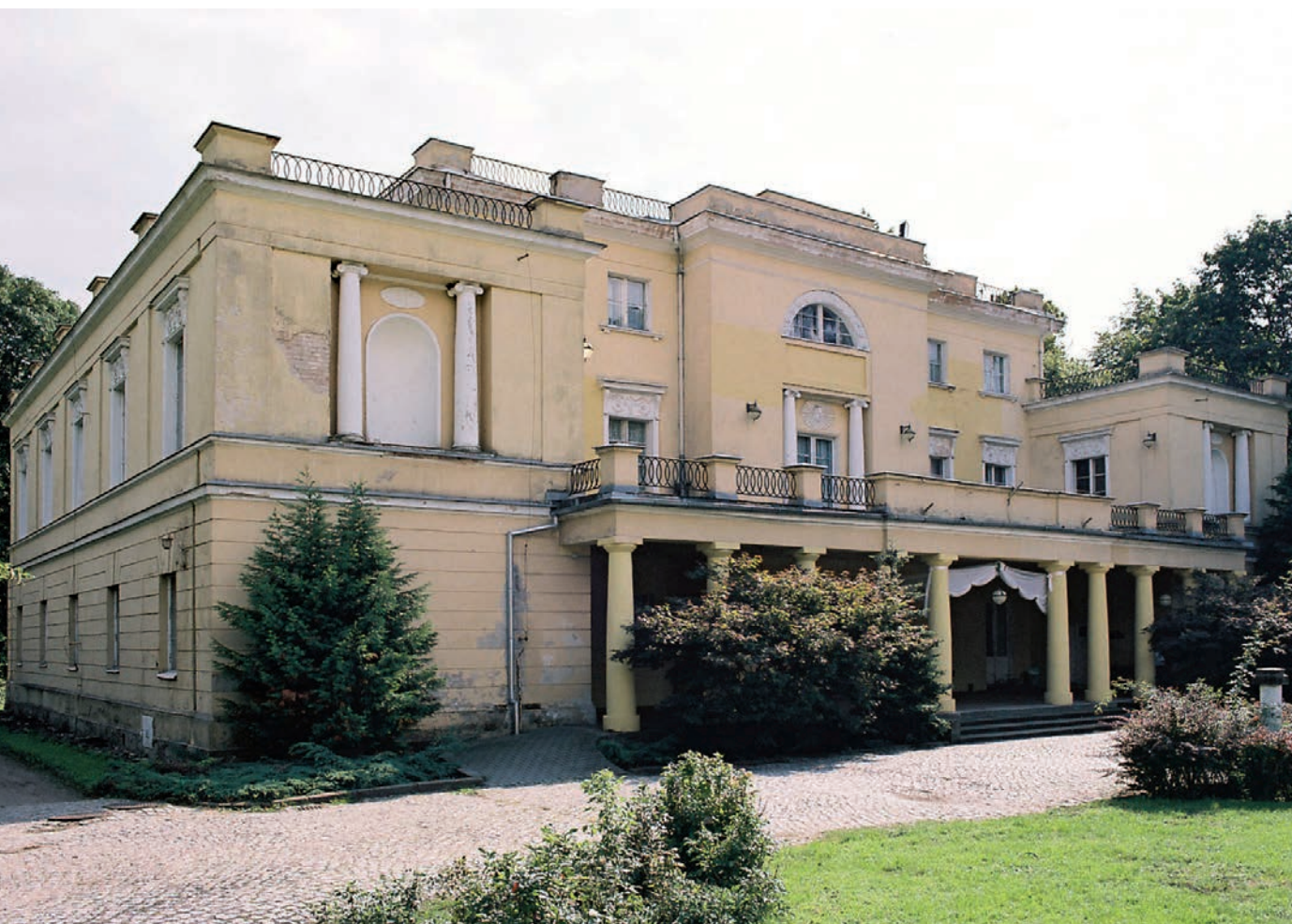
Elewacja północna pałacu w Jankowicach – przed remontem, 2010 r. (ze zbiorów PKZ)
