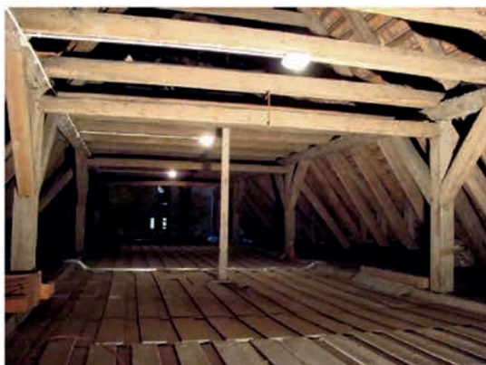
1. Konstrukcja nad nawą
