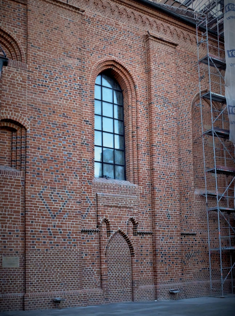
Lico muru północnego z reliktnymi dekoracjami gotyckiej zaburzonej licznymi przemurowaniami
