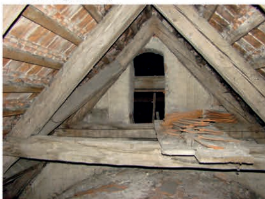
3. Konstrukcja nad prezbiterium
