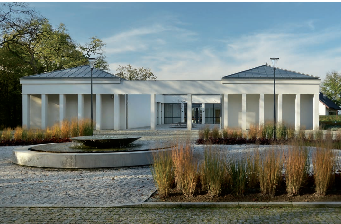
Widok na elewację północną z patio wybudowanego pawilonu
