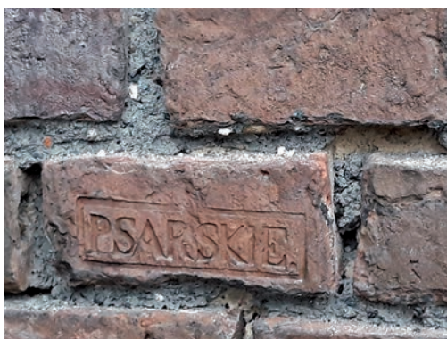
Cegła użyta do przebudowy z czasów Tytusa Działyńskiego z zaznaczeniem polskiej cegielni z miejscowości Psarskie
