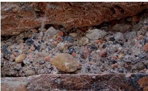
Makroskopowy wygląd spoiny, XIX w. Macroscopic appearance of the weld, the 19 th century
