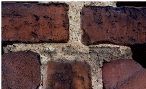
Detal dekoracyjnego fryzu z elewacji z relikwiami XIX-wiecznej spoiny profilowanej
