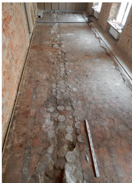
Fot. 10. Posadzka z sześciobocznych płytek ceramicznych odsłonięta w krużganku wschodnim, fot.: D. Olejniczak
