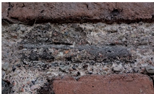
Zachowany relikwiot pierwotnych fug, z warstwą poczerniałego zanieczyszczenia – ściana południowa
