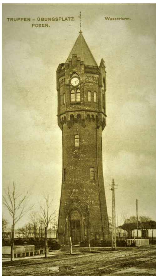
Wieża ciśnień w Biedrusku. Fotografie archiwalne z pocz. XX w.
