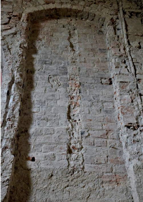
Fragment muru elewacji od strony południowej Fragment of the elevation wall from the south
