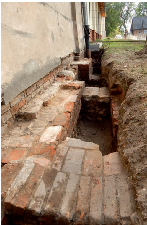
Fot. 2. Przypory przy ścianie zachodniej tzw. budynku kapelanów, fot.: D. Olejniczak
