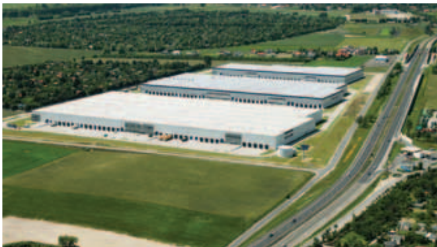
Gądkki, centrum logistyczne Panattoni Park Poznań. Fot. SP
