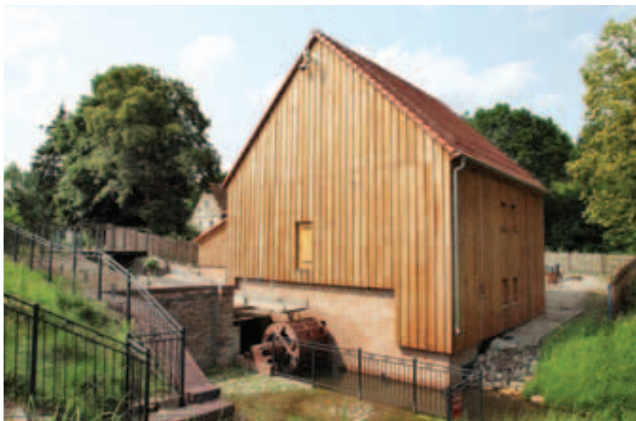
Łysy Młyn, budynek dawnego młyna. Fot. ZS
