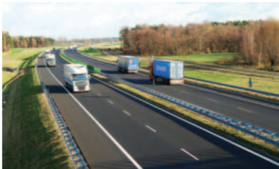
Autostrada A2 koło Tulec. Fot. ZS
