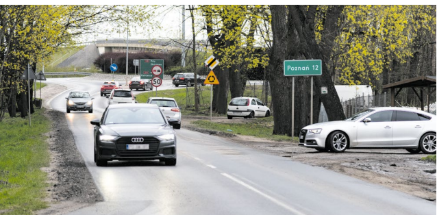
Fragment drogi Palędzie - Dąbrówka, na której powstanie rondo
