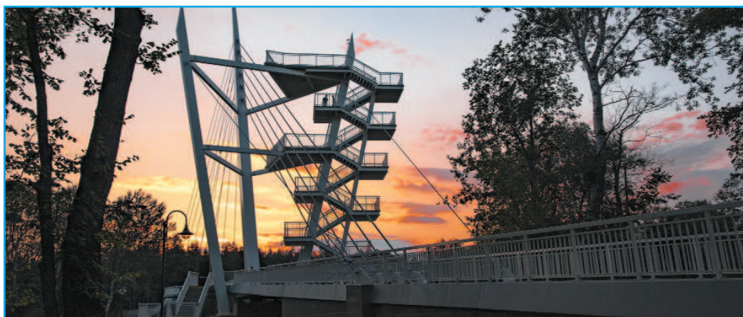
Dolinę Warty można podziwiać w Owińskach, gdzie zbudowano wieżę widokową, towarzyszącą pieszo-rowerowej kładce
